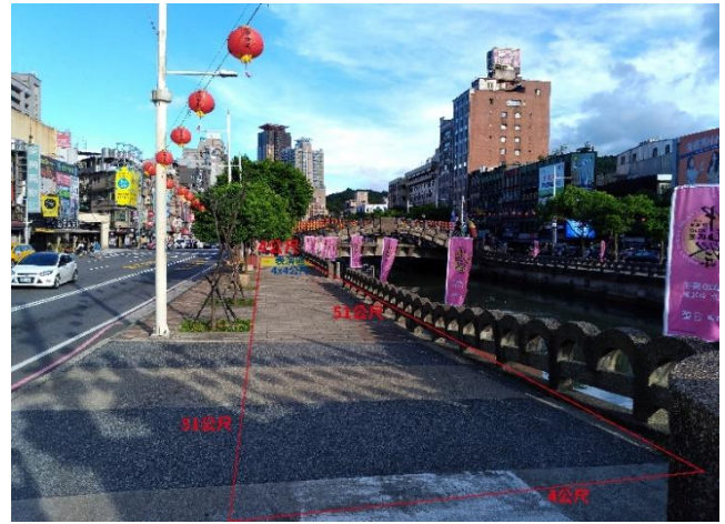
田寮河(二)信一路側富狗橋至金雞橋段
