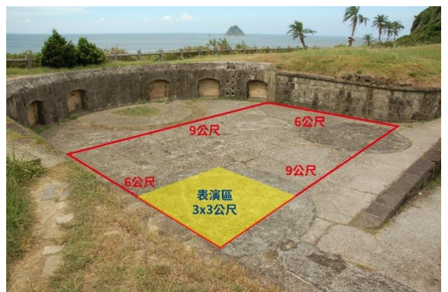
白米甕砲台(4 個砲座區)
